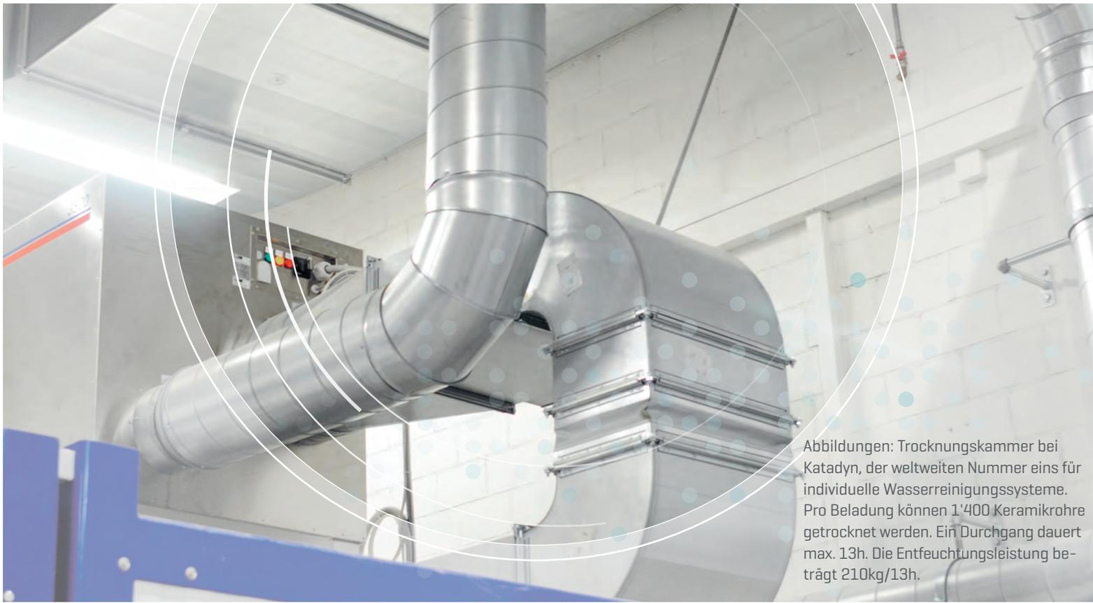
Abbildungen: Trocknungskammer bei Katadyn, der weltweiten Nummer eins für individuelle Wasserreinigungssysteme. Pro Beladung können 1'400 Keramikrohre getrocknet werden. Ein Durchgang dauert max. 13h. Die Entfeuchtungsleistung beträgt 210kg/13h.
