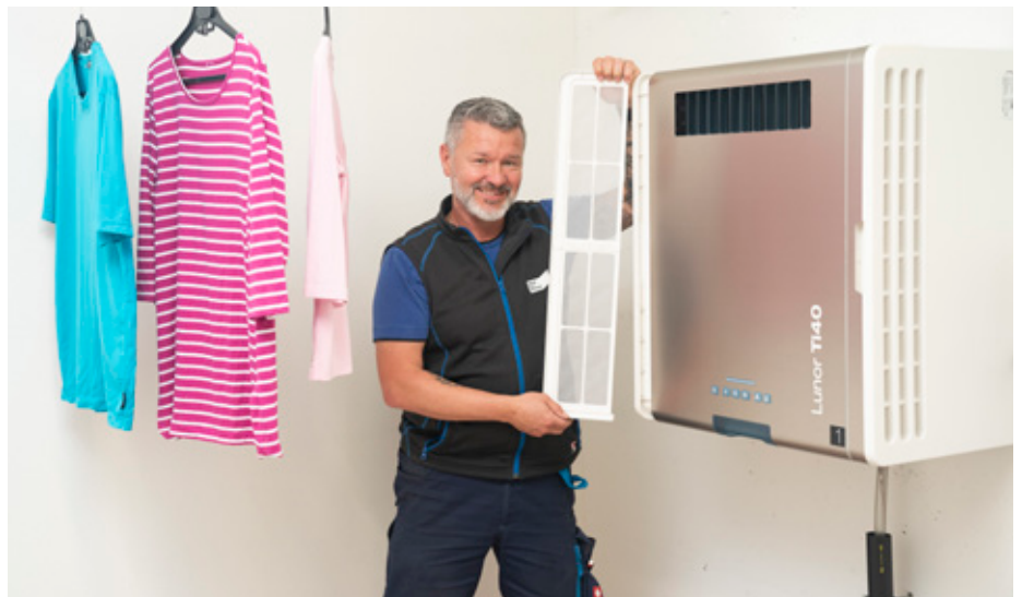
Um die optimale und damit stromsparende Trocknung zu gewährleisten, reinigt Markus Ritter, Hauswart im Hunziker-Areal der Baugenossenschaft «mehr als wohnen», regelmässig die Filter. Einmal jährlich steht eine Revision seitens des Lieferanten an. (Bild: Martin Bichsel für EnergieSchweiz)
